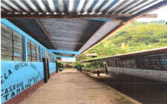
Foto 1: Parte de la cubierta de lámina en el parte frontal de módulo 1, que se encuentra en mal estado.
