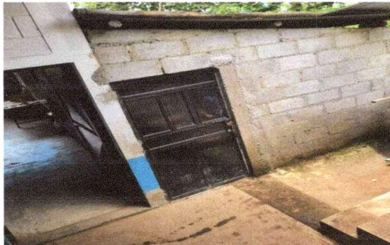
Foto 3: Parte frontal de la cocina que amerita trabajos de sustitucion de cubierta de lámina, repello de paredes.
