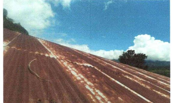
Foto 2: En esta imagen se observa las láminas oxidadas que corresponden a la parte exterior del modulo 1.
